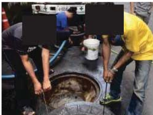
สูบลตะกอนระบบบำบัดน้ำเสีย
