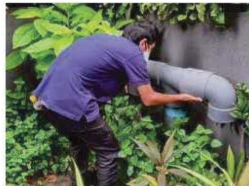
เจ้าหน้าที่เปลี่ยนด้านตัวกลางระบบมีเทน และ Aerosol
