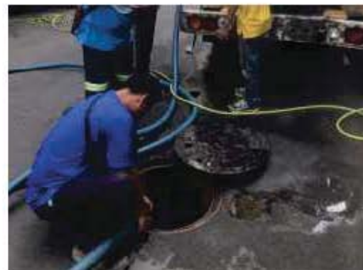
สูบลตะกอนระบบบำบัดน้ำเสีย
